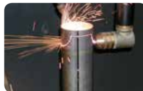
Rohrschnitt Pipe cut
